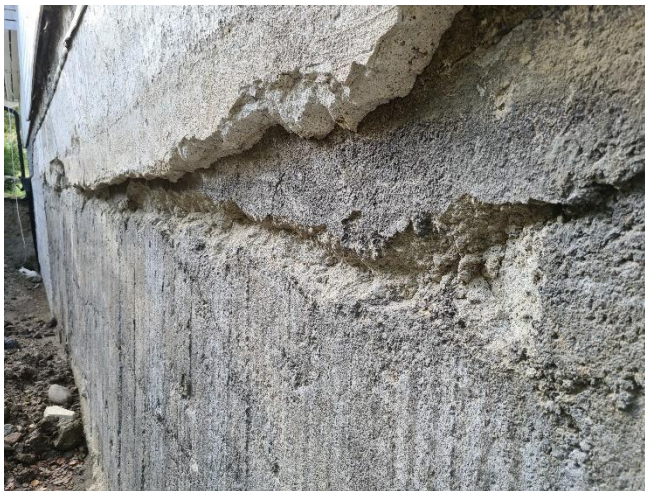
Utvendig påstøp av øvre del, ovenfor knekk på opprinnelig grunnmur
