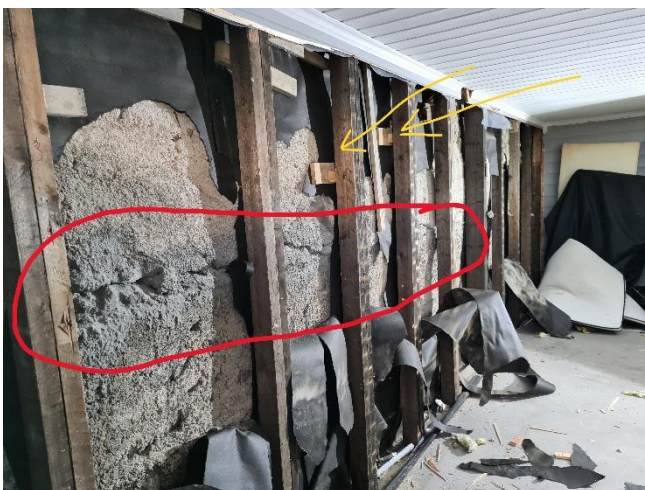
Innvendig side av opprinnelig grunnmur
