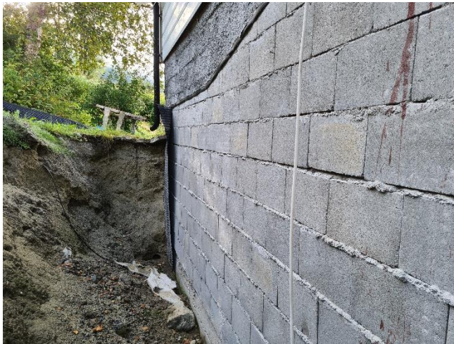
Grunnmur på tilbygget del fra 1996
