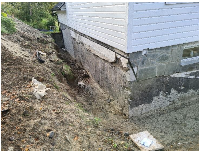
Opprinnelig grunnmur etter oppgraving ovenfor bygningen.
